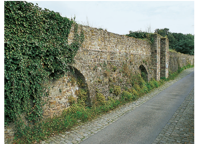
Die restaurierte Stadtbefestigung im Bereich Regenstor.
